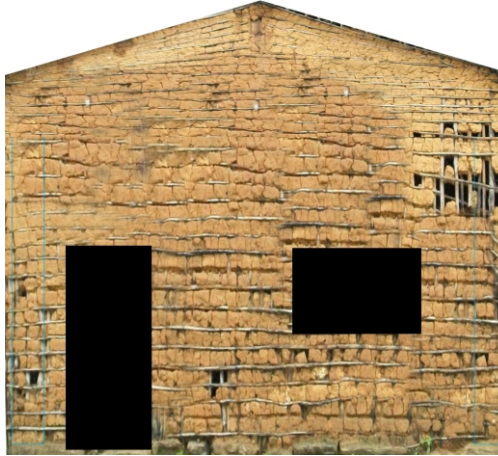
CASA 07 01-Frente 01-Teto 01-Fundo 01-Lateral Inteira 01-Lateral
